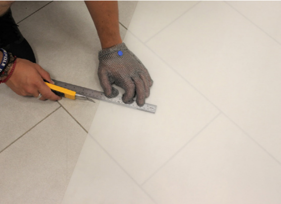
Figura 19: medição e corte das películas de silicone
